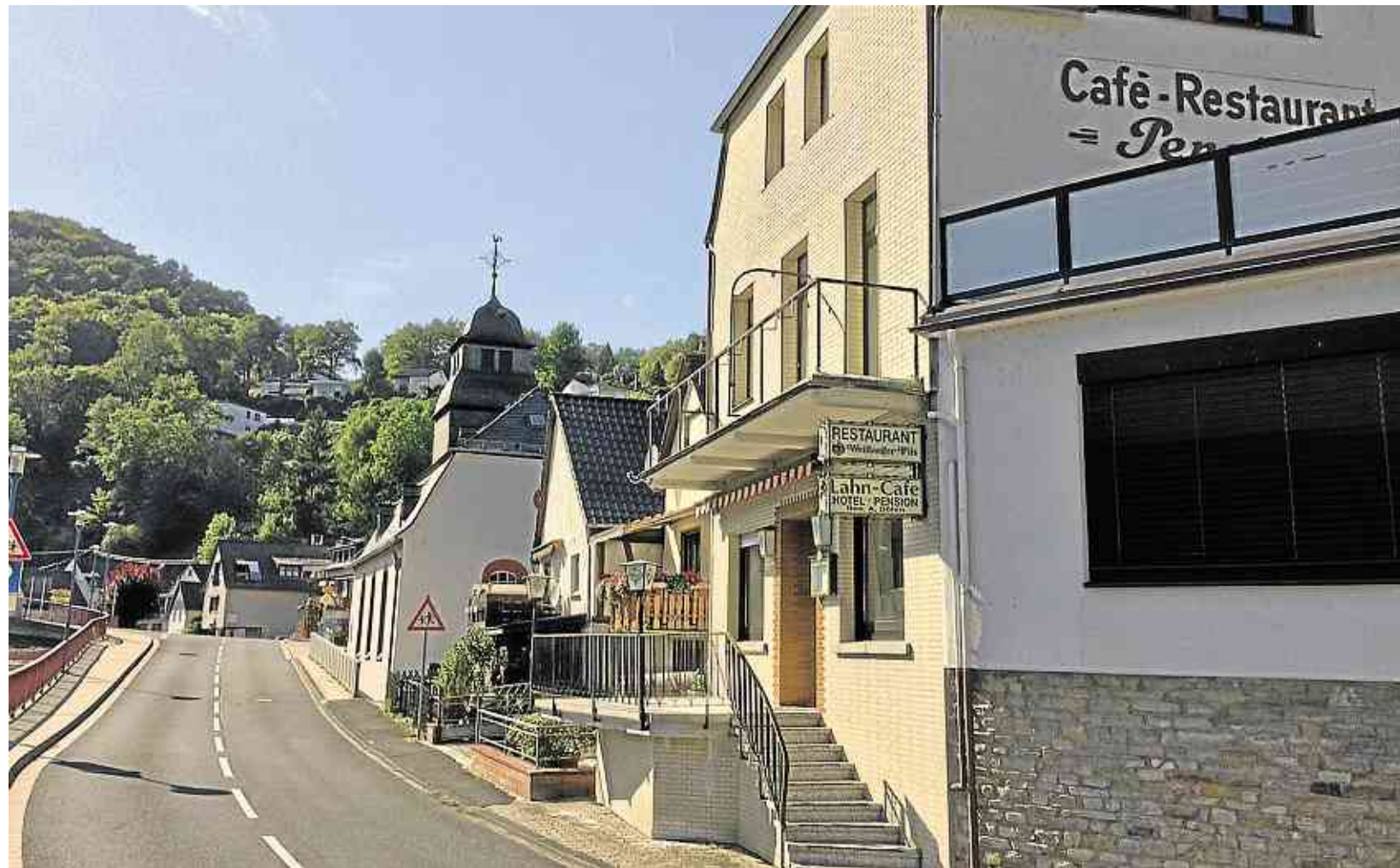
Das ehemalige Lahn-Café an der Obernhof Hauptstraße steht seit drei Jahren leer. Im Oktober soll es als „Hotel am Goetheberg“ mit 13 Zimmern wieder den Betrieb aufnehmen. Derzeit laufen die Renovierungsarbeiten. Foto: Carlo Rosenkranz
